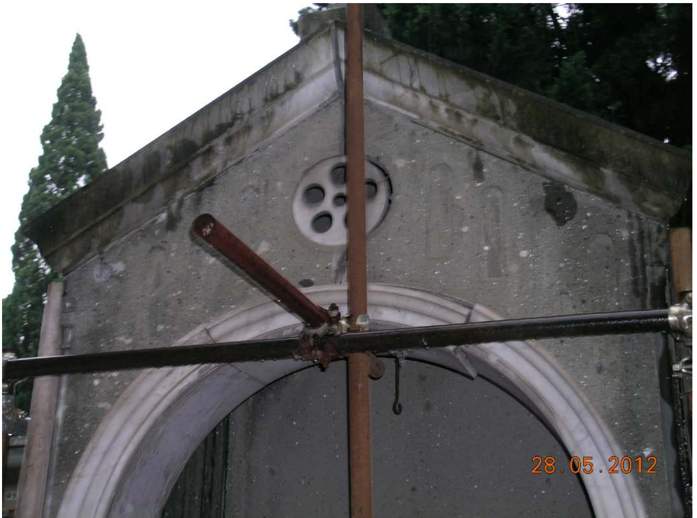
Particolare della parte sommitale
